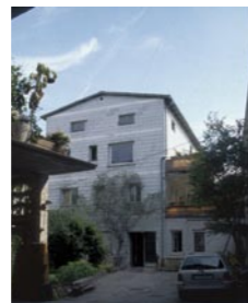
Beispiel für Sanierungsbedarf
