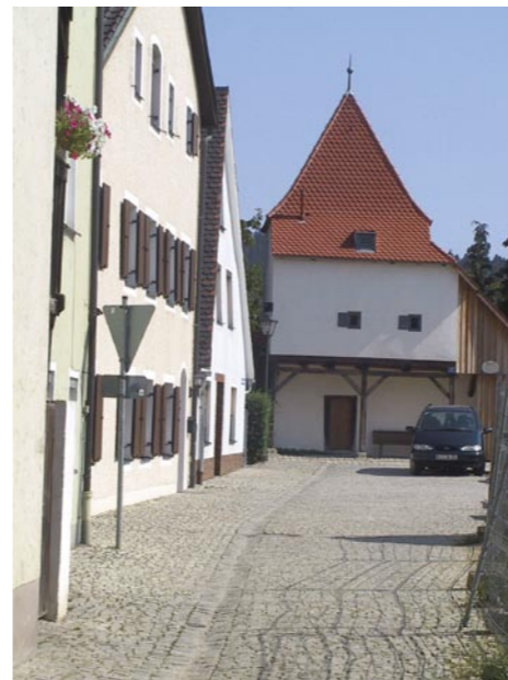
Roßturm Die Stadtbefestigungsanlagen samt Türme wurden saniert
