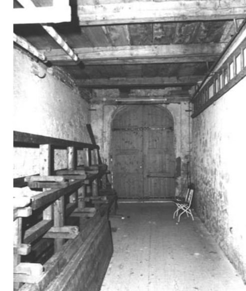
Eingangssituation vor der Sanierung
